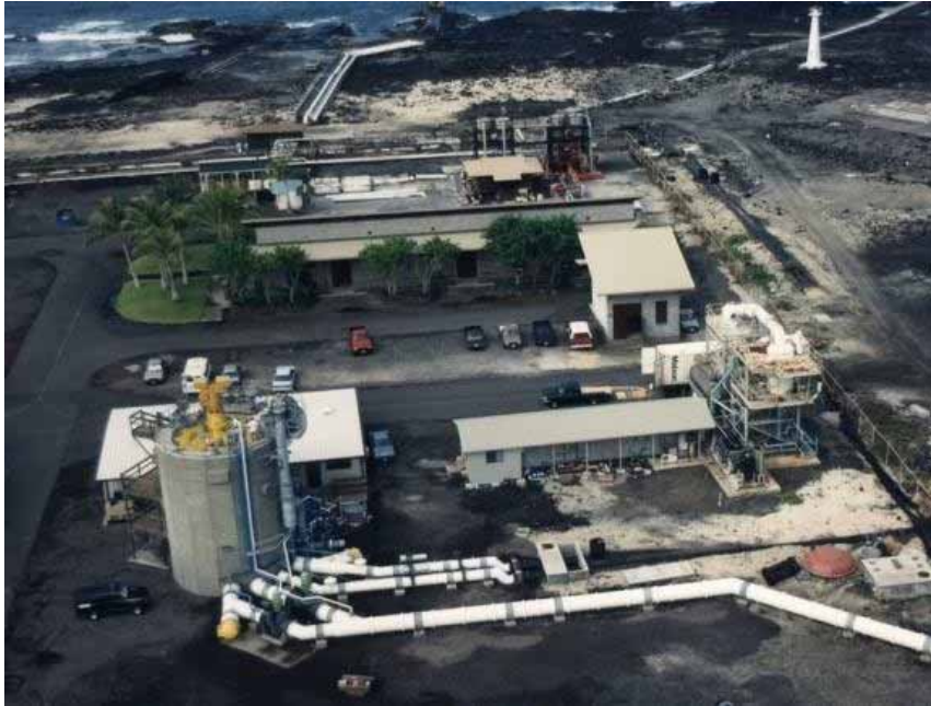
Figura 110. CETO de ciclo abierto, Keahole, Hawaii
