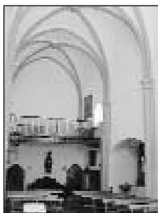
Fig. 14. Bóvedas del edificio.
