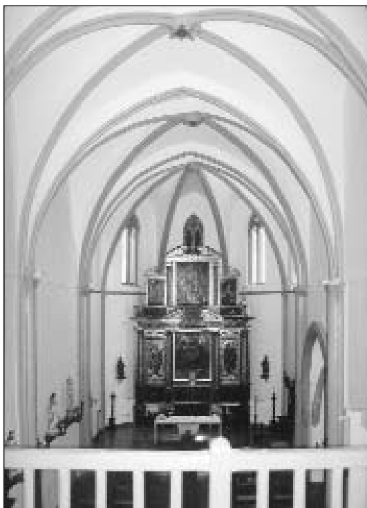
Fig. 20. Vista del interior.
