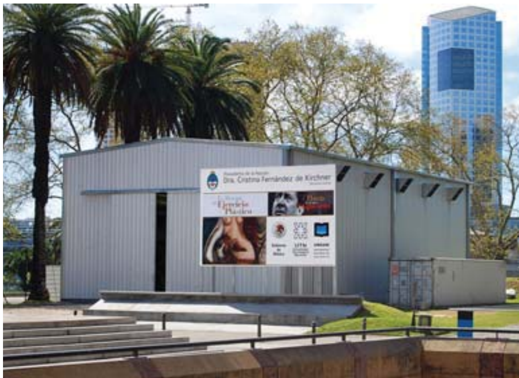
Figura 8. Galpón principal donde se hizo el trabajo de restauración, en el parque de la Casa de Gobierno.
