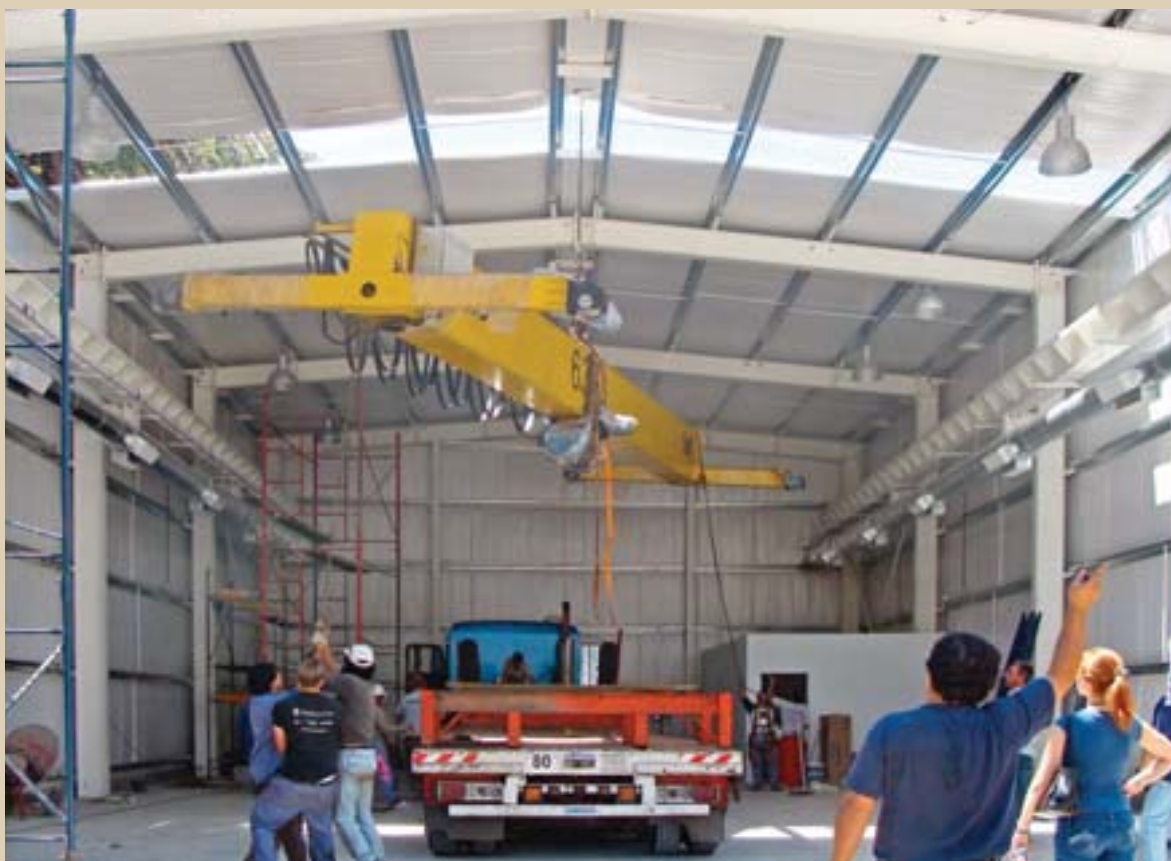
Figuras 261 y 262. Dos vistas del armado del galpón para la restauración del mural en la Casa de Gobierno.
