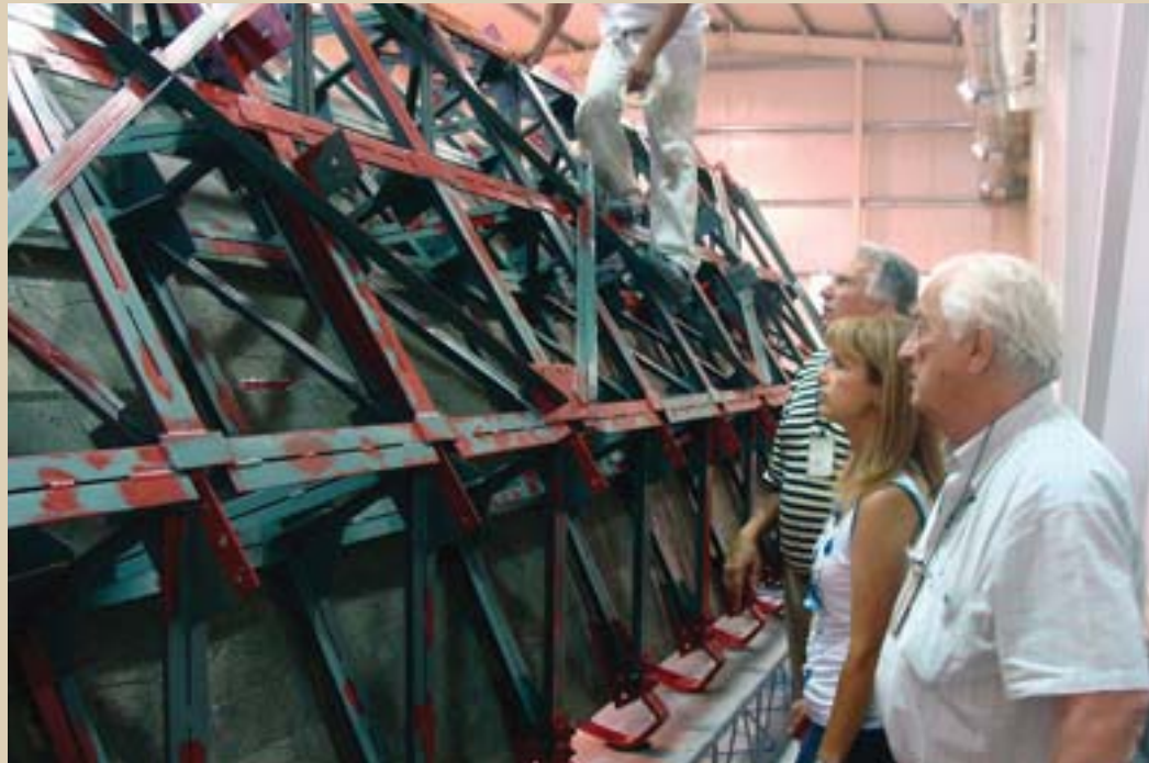
Figura 266 . La restauración completa de la estructura metálica oxidada.
