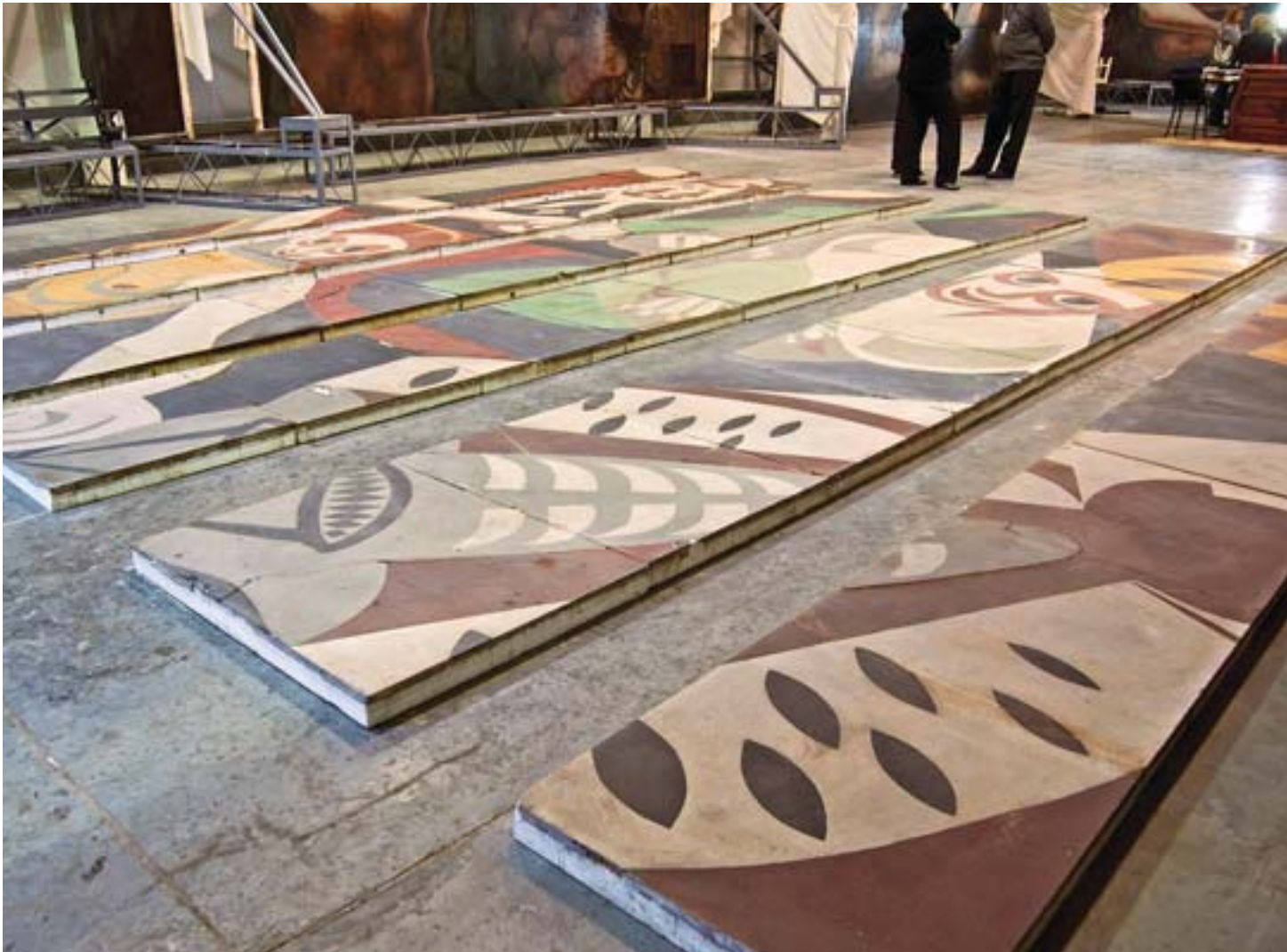
Figura 248. Armado del piso para completar la restauración, una vez rehecha la base.
