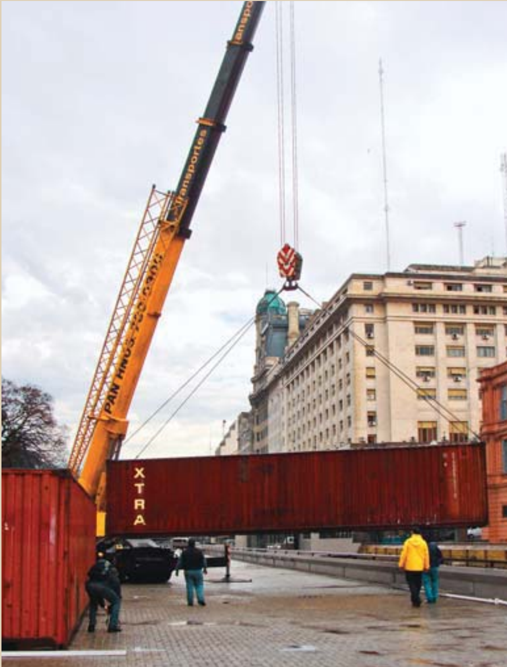
Figura 260. Una grúa izando el contenedor para ubicarlo en su lugar provisorio.
