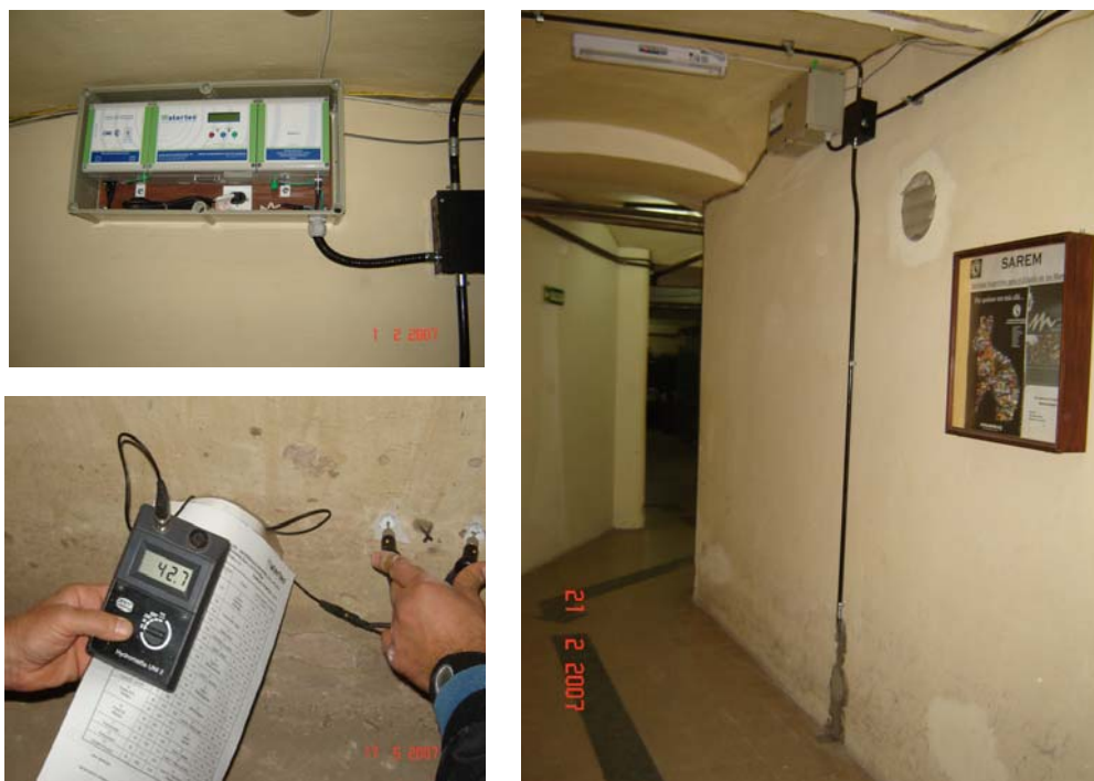
Fotografía 11 y 12. Equipos de electroósmosis activa Fotografía 13. Testigos y aparato de medición
